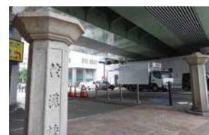
高架道路下に残る橋柱(信濃橋) 64
