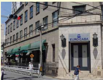
大阪農林会館 南船場3丁目2-6 57 1930年(昭和5)の建築。元三菱商事大阪支店、現在はテナントビルとなっている。
