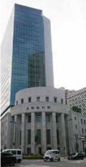
大阪証券取引所ビル 北浜1丁目8-16 2 1935年(昭和10)築、2004年(平成16)に全面増改築。橋円筒形の旧市場館部と外壁・内壁の一部が保存された。五代友厚の像が立つ。
