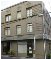
伏見ビル 伏見町2丁目2-3 17 1923年(大正12)築。登録有形文化財。船場倶楽部事務局も入居。
