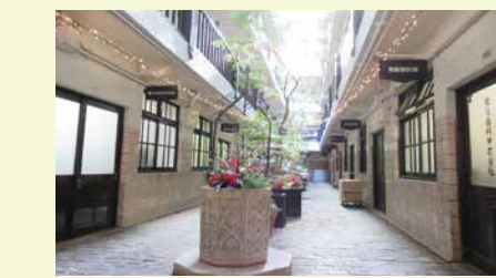
清水猛商店 27 淡路町3丁目5-6 1924年(大正13)築。木造3階建て、船場の商家が町家から西洋建築へ移行する過渡期の貴重な事例。
