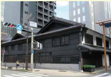
旧小西儀助商店 道修町1丁目6-9 20 1903年(明治36)築。国の重要文化財。2代目儀助が木材から意匠までこだわり抜き3年かけて完成。
