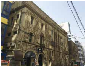
工事完了の2018年3月頃
