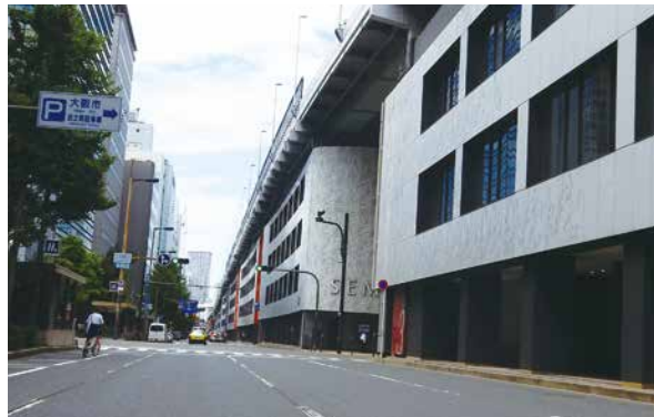
船場センタービル外観 3号館から西を望む
