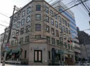
角地を強調した外観
