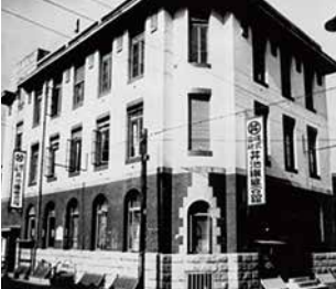
当時の井池繊維会館
