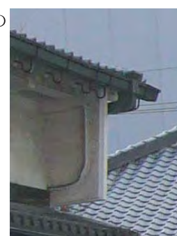
左) つし2階部分の卯建 中) 屋根付き卯建 右) 屋根卯建
