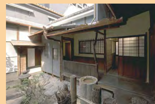
上) 敷地全景 下) 中庭の様子
