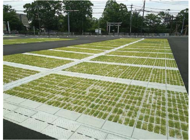
▲緑化ブロック舗装の事例
