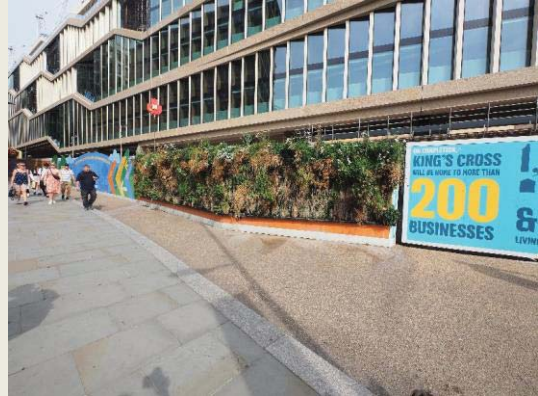
▲緑化された工事仮囲い (ロンドン キングスクロス再開発)
