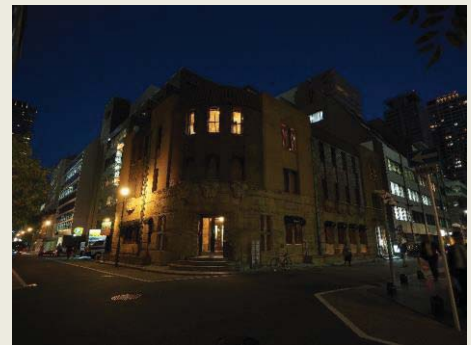
▲改善後の道路照明灯
