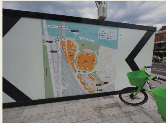
▲案内サインを表示した工事仮囲い (ロンドン バタシー発電所再開発)
