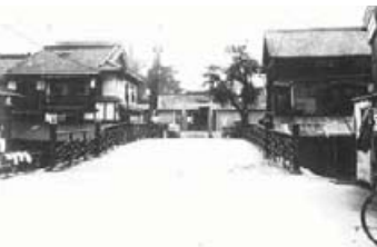
火防陶器神社への参道 新渡辺橋②「埋もれた西区の川と橋」
