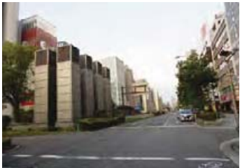
長堀通の排気筒・四ツ橋から東を望む
